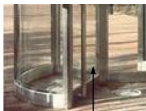
Obramowane bezpieczne panele szklane laminowane 11.5mm
